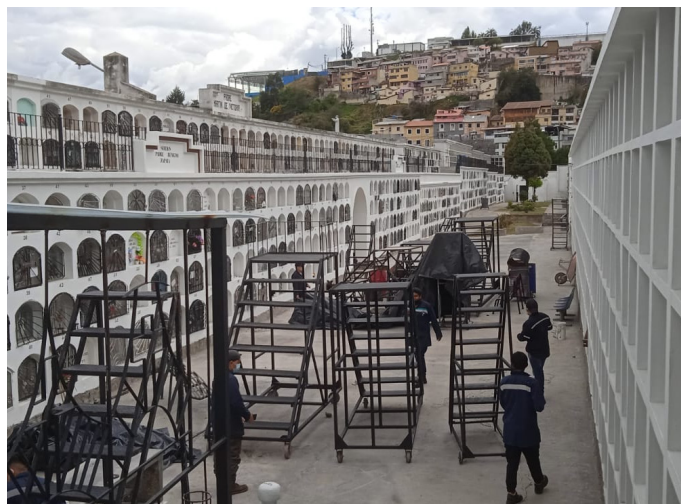
Figura Nro. 36: Mantenimiento de escalinatas metálicas en el Cementerio de El Tejar - Quito
