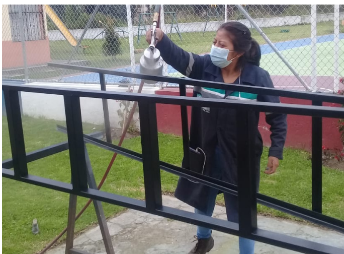
Figura Nro.37: Trabajos de mantenimiento en las instalaciones del INHAMI - Quito
